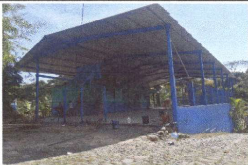
Foto1: Sustrucción de lámina por lámina troquelada aluzinc calibre 26 mas sustrucción de estructura de soporte de metal por metal.
