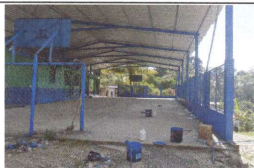
Foto 5: Pintura en muros exteriores e interiores
