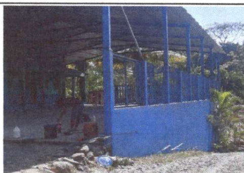
Foto 4: Pintura en muros exteriores e interiores
