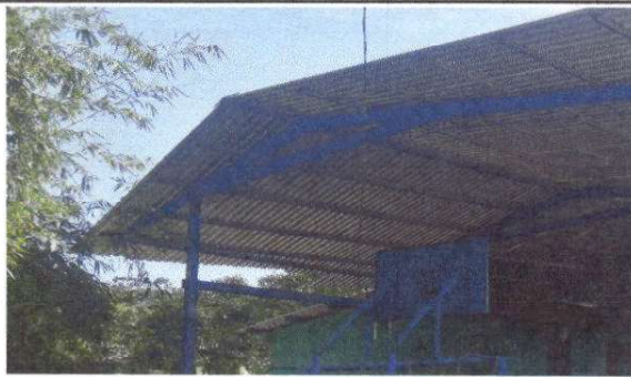
Foto 2: Sustrucción de capote para lamina troquelada.
